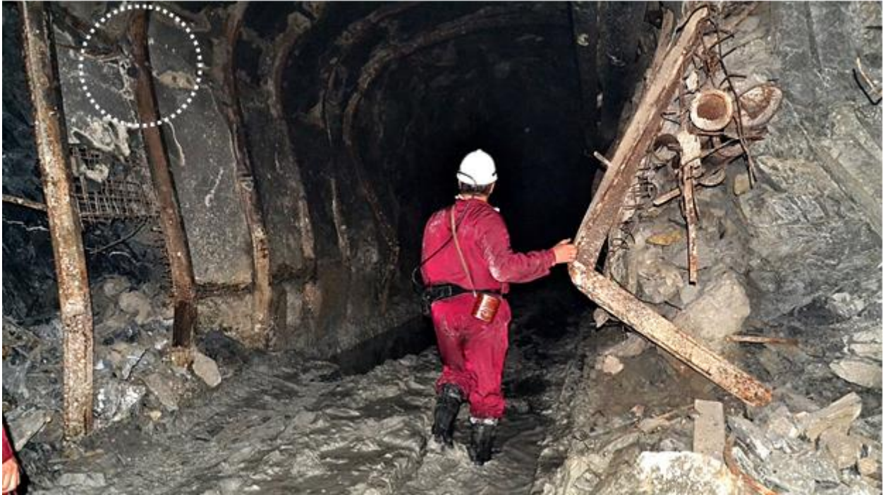
Рисунок 4 – Расположение узлов податливости в пятах свода (выделено) и излом плоских стоек рамной крепи из-за отсутствия вертикальной податливости
